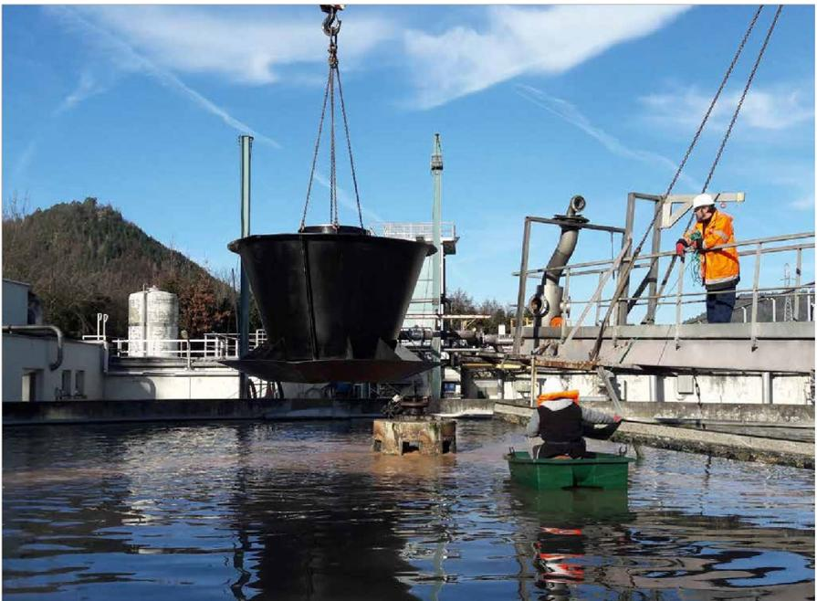
*Dispositif permettant d'améliorer la décantation des matières en suspension Station d'épuration des Papeteries de Clairefontaine*
