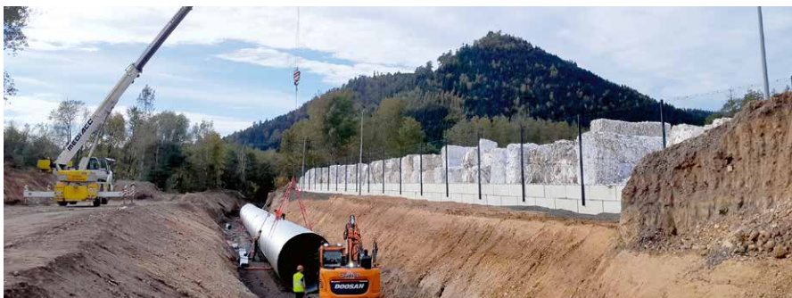
Papeteries de Clairefontaine – Installation d'une rétention pour les eaux d'extinction incendie
