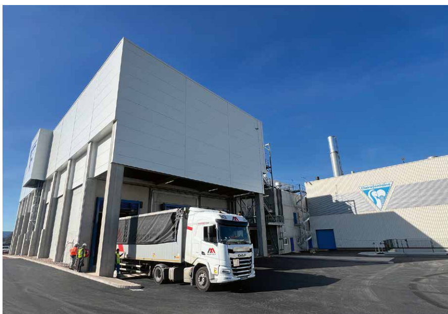
Papeteries de Clairefontaine – Chaudière biomasse
